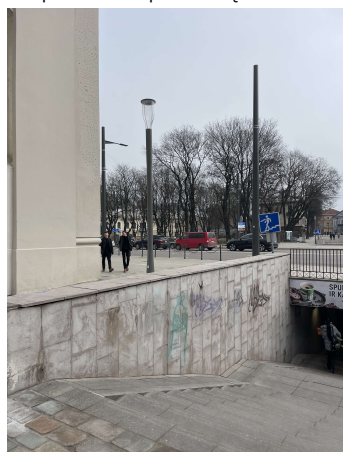
5. Pėsčiųjų tunelio sienų plokščių dabartinė situacija. Esamos tunelio sienos yra praradusios savo spalvą, nusidevėjusios, vietomis suskilusios, pažeistos vandens.
